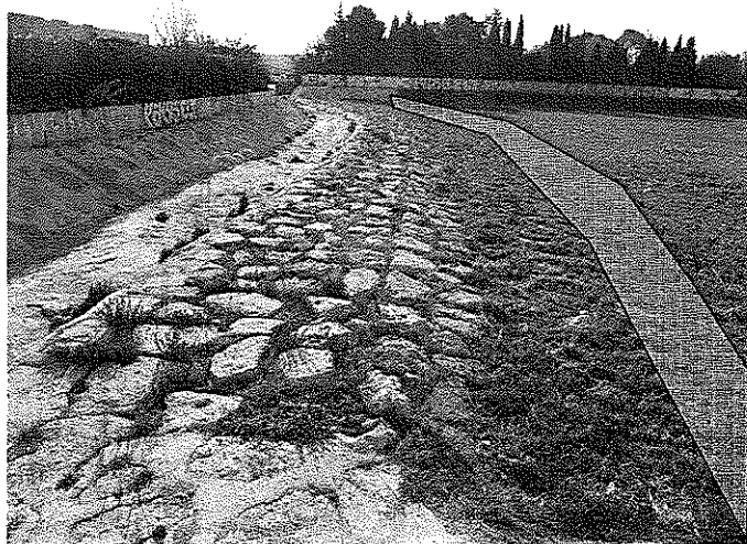
Vue depuis l'extrémité Sud du cadereau à rénover, vers le Sud.
