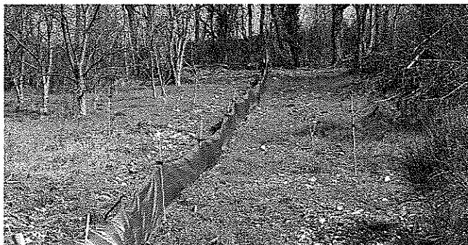
Exemple type de bâchage enterré en prévention du déplacement de petite faune
